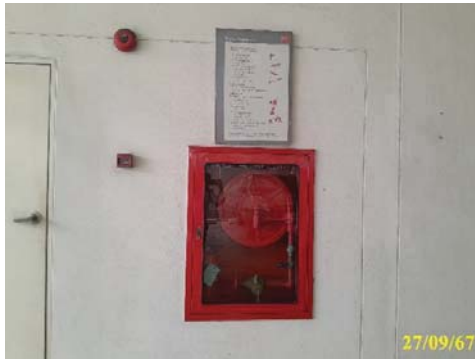
สายฉีดน้ำดับเพลิง (Fire Hose Cabinet : FHC)
